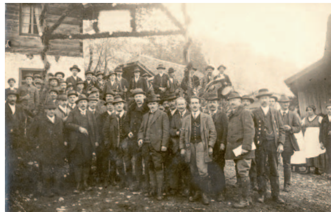
Einweihungsfeier der Mörtelbachstraße beim Sagwirt 1921
